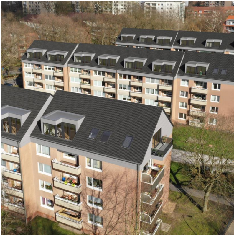
Aufstockung Wohnanlage, Hamburg-Horn, Seysta | Seyfarth Stahlhut Partner mbb
