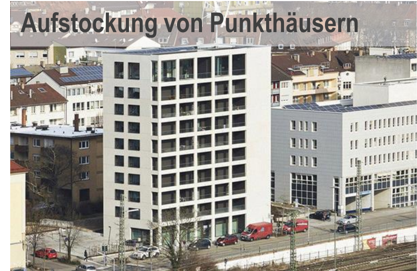
Aufstockung und Generalsanierung Wohnhochhaus Pforzheim, Freivogel Architekten
